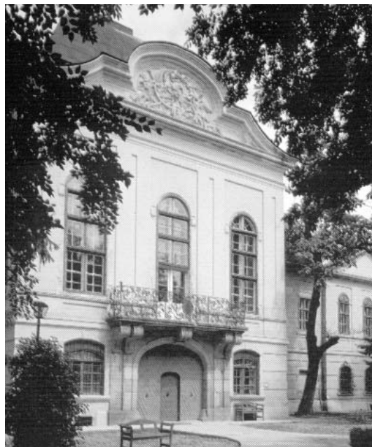
A Ráday-kastély főhomlokzata
