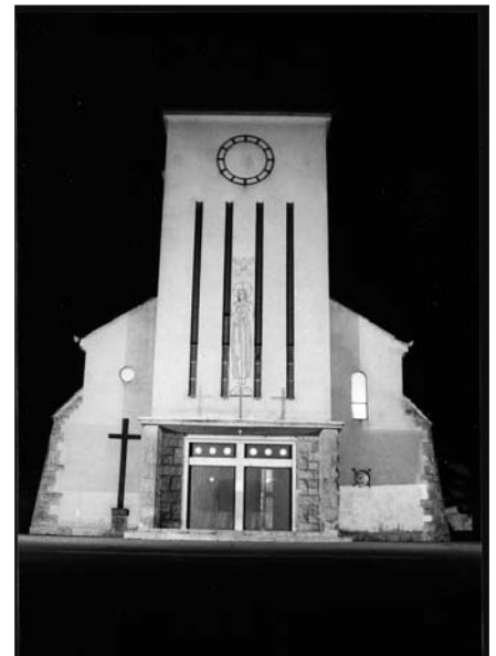
Templomunk új, esti megvilágításban
